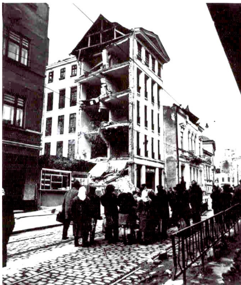
Fig. 3. Prăbușirea unei părți dintr-o clădire veche din București, insuficient de rezistentă la seisme. Ca urmare a cutremurului vrâncean din 4 martie 1977, pereții din zidărie s-au prăbușit în stradă și au pus în pericol trecătorii
