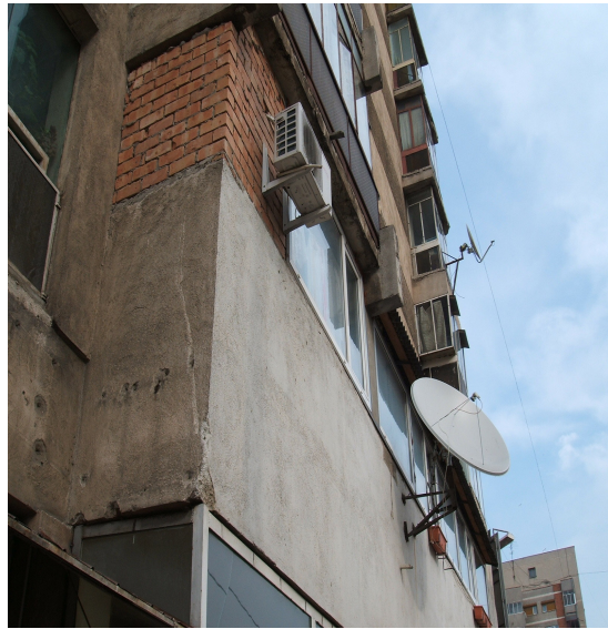
Balcoane cu închideri improvizate, geamuri, antene și aparate de aer condiționat care pot să cadă la seism sau furtună
